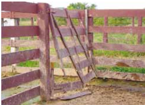
INSTALAÇÕES EM MAU ESTADO DE CONSERVAÇÃO
